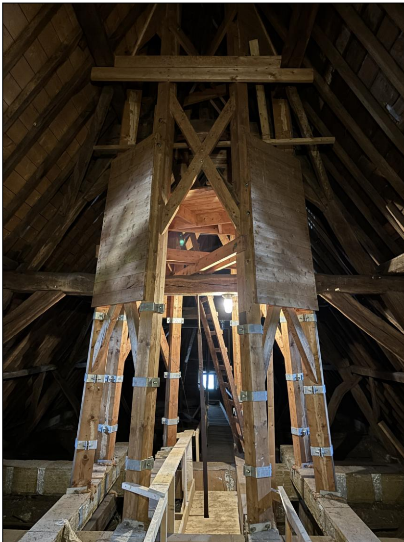
Fig. 23. Onderste deel van de Angelustoren, gefotografeerd op de zolder van het middenschip in oostelijke richting. Alle ondersteunende balkwerk is vernieuwd in 1990. Foto: Alfons Bruekers.
