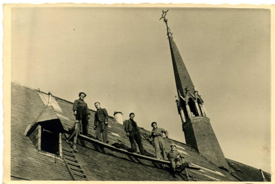
Fig. 13. De vernieuwde Angelustoren is gereed en dakdekkers van de firma Verkoelen zijn bezig met het dak van het middenschip. Rechtsomder (zittend) aannemer Piet Scheijven. Foto: Jan Biezenaar, collectie SGN.
