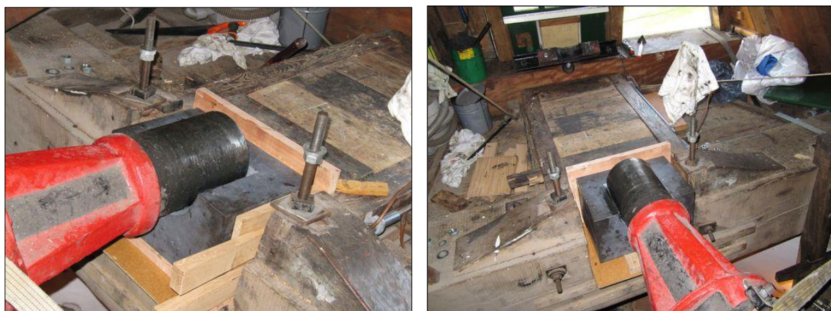
Fig. 16 en 17. Moderne broeksteen van windmolen Windlust in Wieringen met daarin de gietijzeren 'muts' van de wiekenas. Foto's: www.westlandsemolens.nl .
