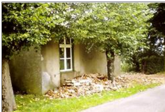
Fig. 7. Gecementeerde westgevel (Molenwegzijde).
