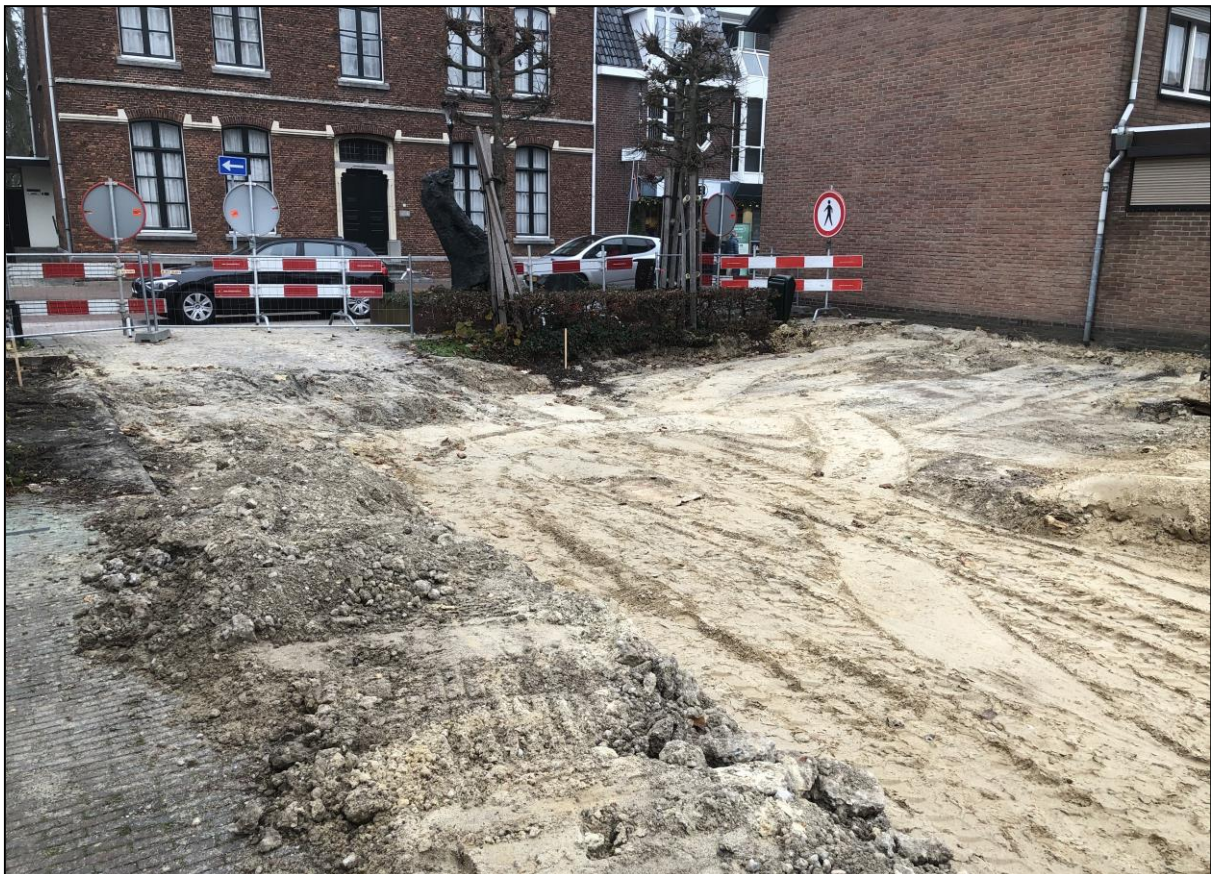
Fig. 18. Het uitgegraven en weer aangevulde wegcunet gezien in oostelijke richting op de plek van de voormalige 'Dubbele Kapelanie'. Achteraan ligt de Kerkstraat. Datum opname: 10 december. Foto: STRABO.
