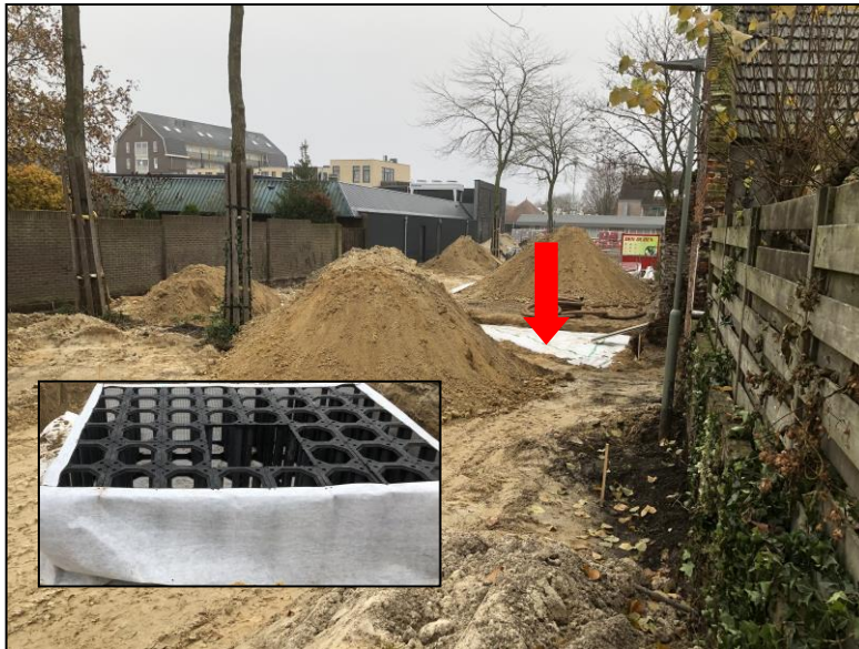
Fig. 20. Ter plaatse van het witte plastic (bij de rode pijl) is een diepe en grote kunststof krattenbak ingegraven (zie inzet). Datum opname: 10 december 2022. Foto: STRABO.
