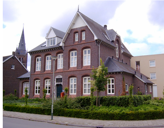
De pastorie in de Schoolstraat die in 1881 door pastoor Lambert van de Winkel werd gebouwd.
