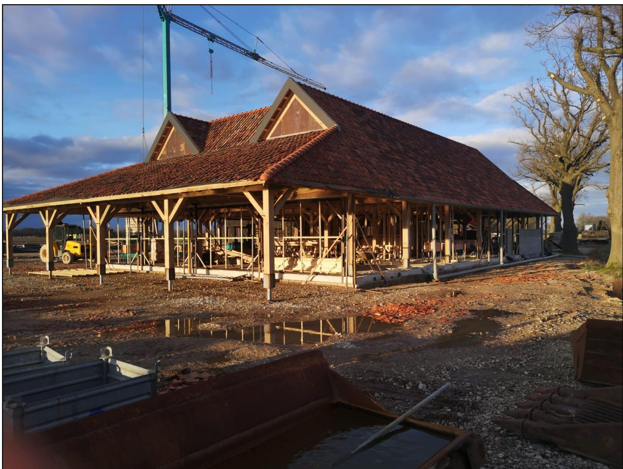
Fig. 5. Het paviljoen in aanbouw. Situatie februari 2024. Foto: Hoeve de Zwingel.
