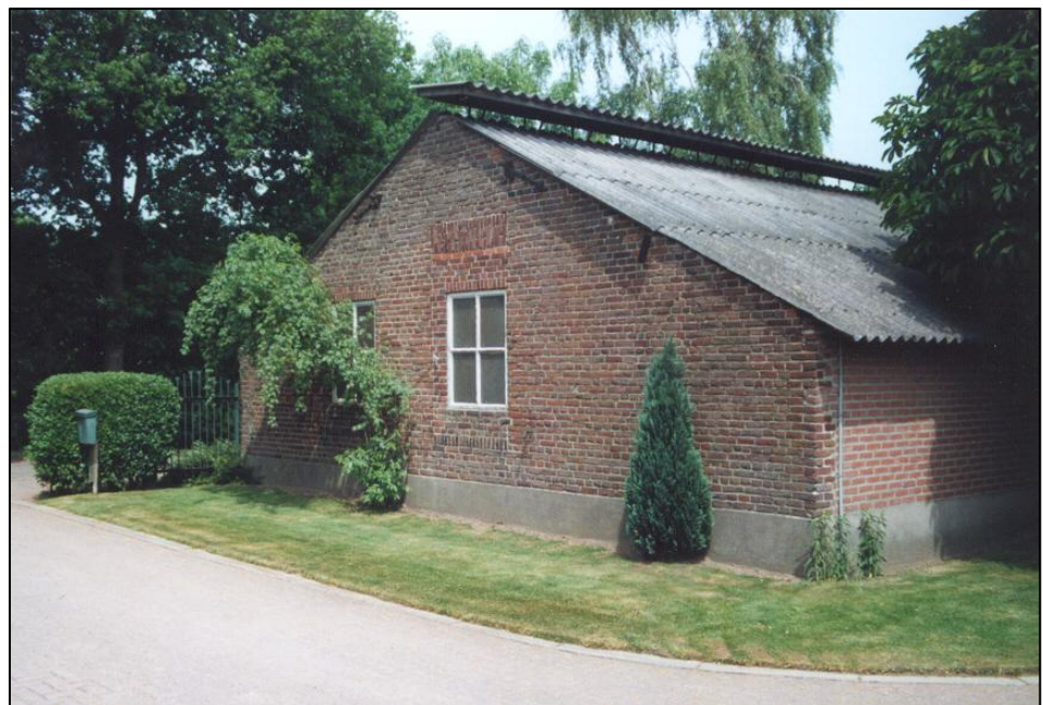
Restant van de westelijke kopgevel van de woning van Simon van Roij. Situatie in 2002, nadien is het gebouw afgebroken en vervangen door nieuwbouw. Foto Alfons Bruekers.
