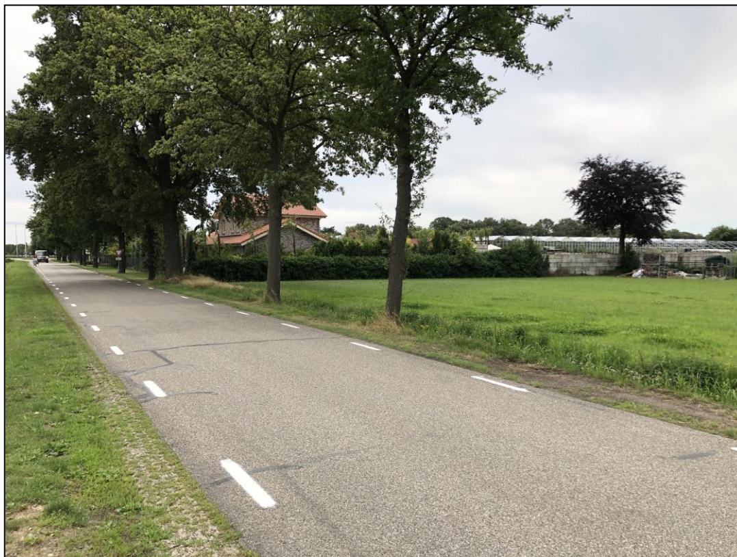
Fig. 18. Waatskamp, Ospel, gezien naar het zuidwesten. Aan de rechterzijde van de straat bevond zich het munitiedepot. Foto: Alfons Bruekers, opnamedatum 18 juli 2023.
