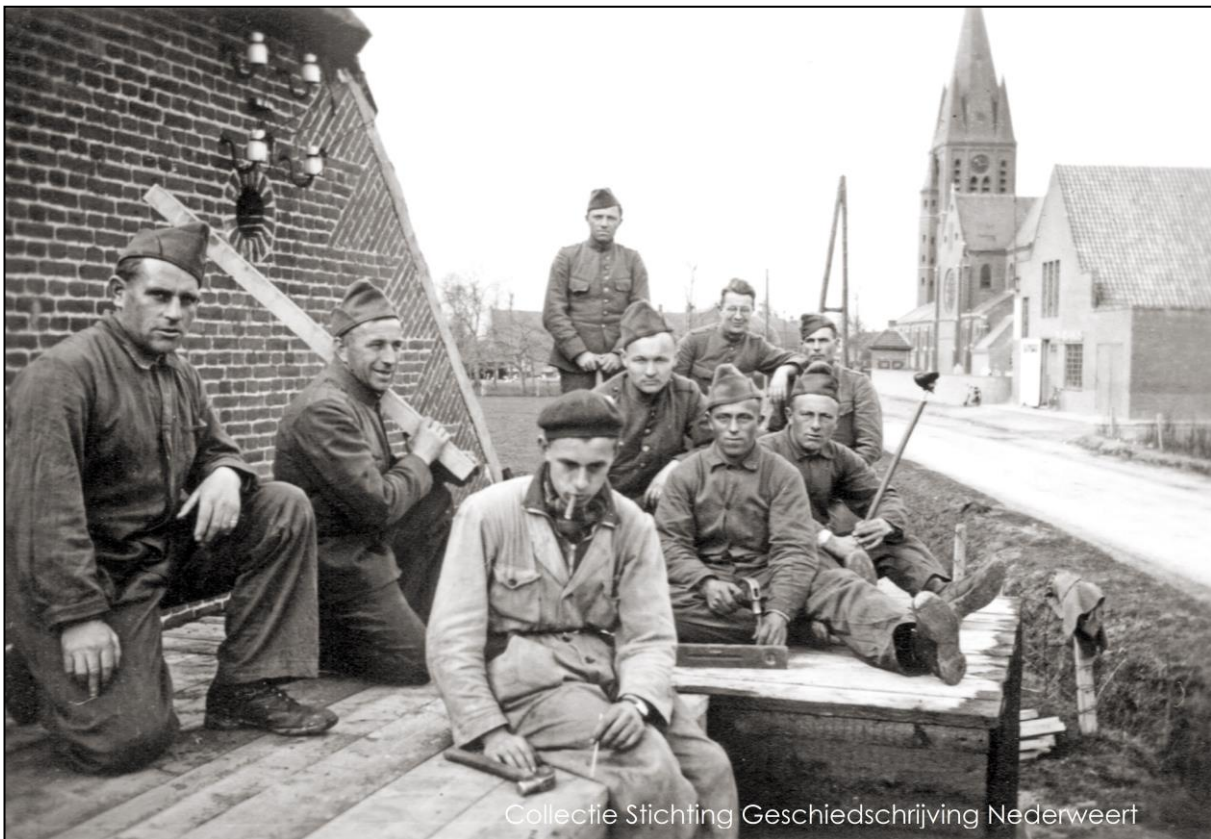
Fig. 1. Troepen van de Genie van het Nederlandse leger bezig met de aanleg van versterkingen en schuilplaatsen in Ospel-Waatskamp in 1939. Collectie Stichting Geschiedschrijving Nederweert.
