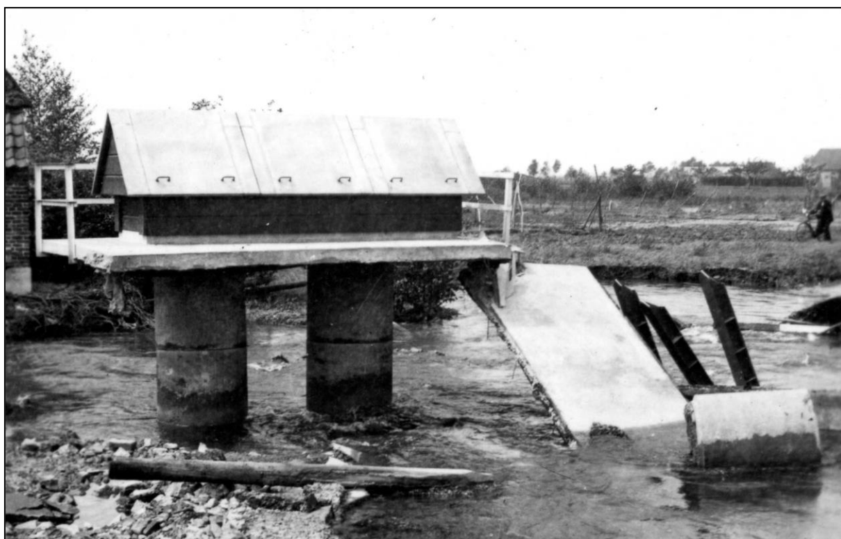
Fig. 9. Aspergestelling langs de Zuid-Willemsvaart na dijkdoorbraak in 1940. Ter vergelijking met de vondsten van de Wessemerdijk. Geheel rechts de stalen palen van de 'asperges'. Het palenhuisje staat op een horizontaal betonnen plateau dat gefundeerd is op betonnen putringen. Dezelfde elementen zijn teruggevonden aan de Wessemerdijk. Foto: collectie SGN.
