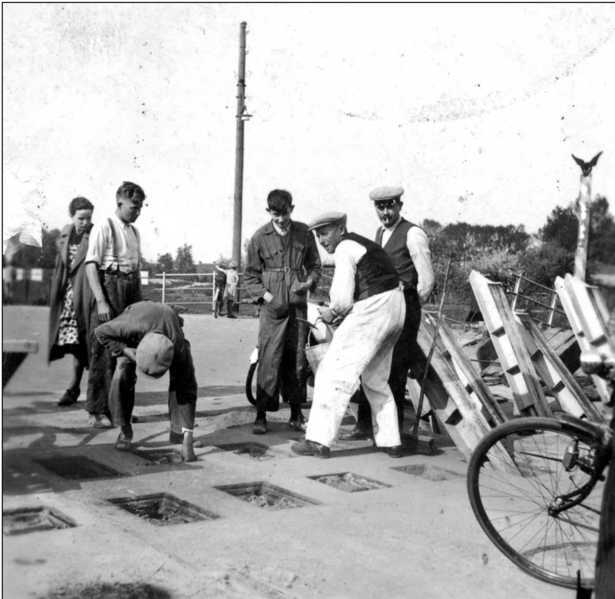
Fig. 14. Het verwijderen van de stalen balken uit de 'aspergestelling' aan de westzijde van Brug 15. De man met de sigaret is smid Fons Bruekers (1891-1970) en de jongeman met overall en de handen in zijn zakken is diens oudste zoon Jean Bruekers (1923-2014). Respectievelijk grootvader en vader van de auteur. Foto: collectie SGN.
