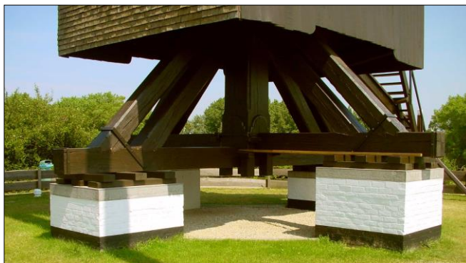
Fig. 12 en 13. Voorbeelden van een sokkel van teerlingen met opgaand kruiwerk van een standaardmolen (tekening en foto: internet, Google Afbeeldingen).
