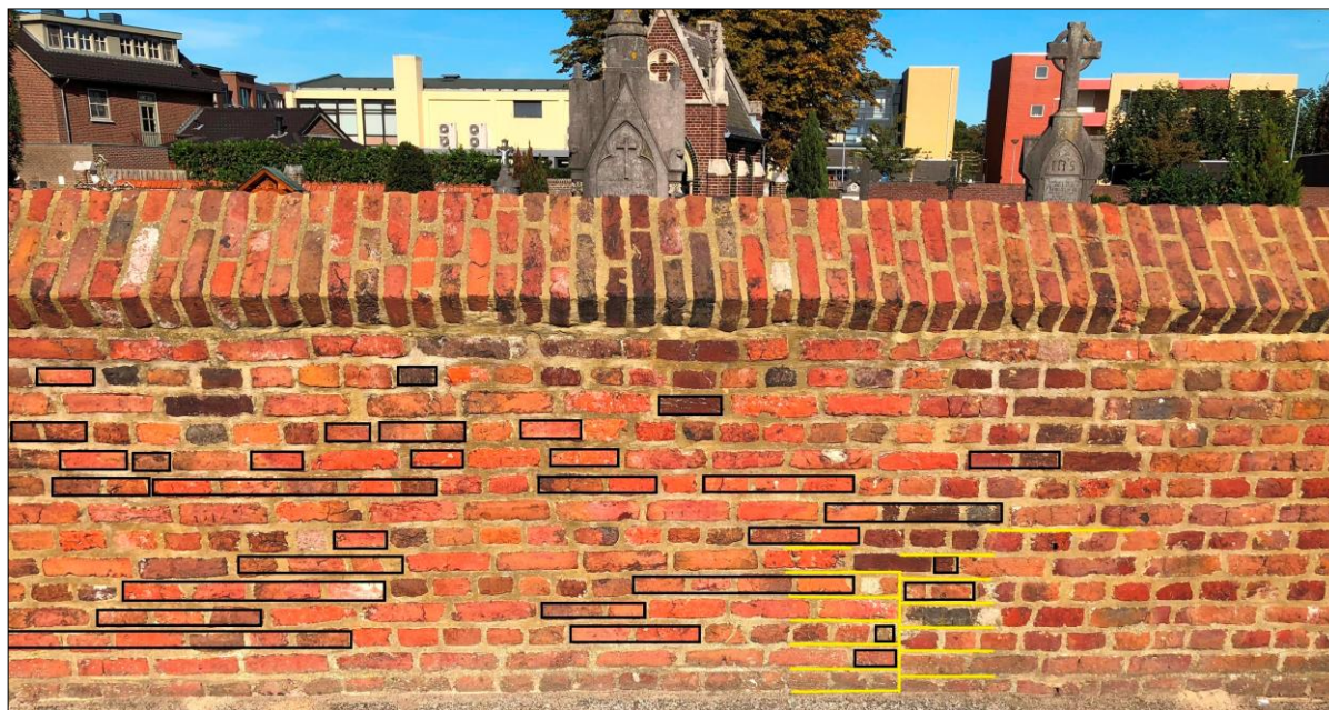
Fig. 4. Westzijde of buitenzijde van de kerkhofmuur. In geel: bouwnaad en hoogteverschil van de liggende voegen. Links daarvan onregelmatigheden in metselverband en grootte van de bakstenen (zwart aangeduid). Rechts van de bouwnaad overwegend regelmatig metselverband en steenmaat. De donkerbruine stenen vertegenwoordigen naoorlogse reparaties en inboetingen. Foto: Alfons Bruekers, situatie 2018.
