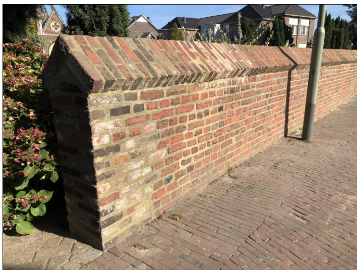
Fig. 8. Omstreeks 2010 verkorte en aangeheelde kopse kant van de kerkhofmuur aan de kerkzijde. Deze plaats correspondeert met de overgang van de gele naar de blauwe zone in de figuur hierboven.
