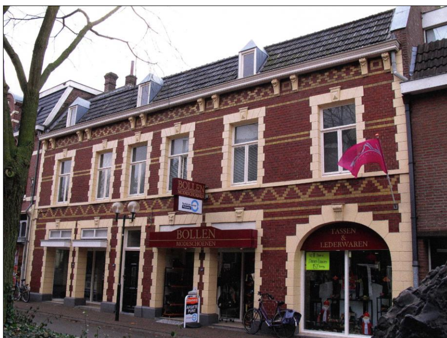
Fig. 9. Situatie na de renovatie van 1986. De borstweringen van de vensteropeningen zijn verdwenen en de vensters zijn verbreed. Foto: van Traa, 2009.
