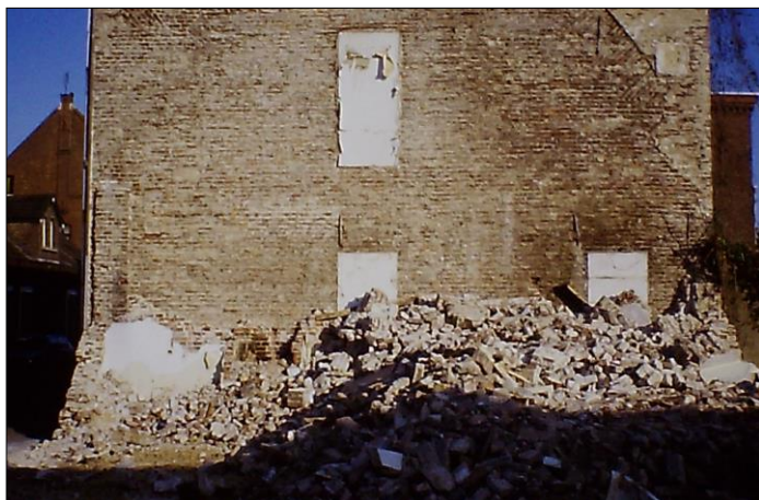
Fig. 3. De vrijgekomen noordgevel tijdens de afbraak van belendend pand Kerkstraat 47, situatie in juni 1985. Foto's: Alfons Bruekers.
