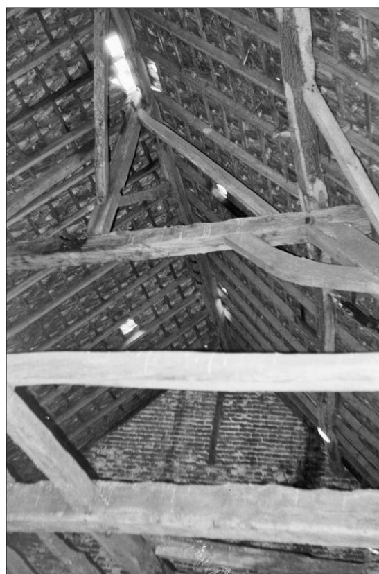
Fig. 8. Kapspanten van het achtergedeelte uit 1798. Foto: RCE 150.656 Ab Warffemius.
