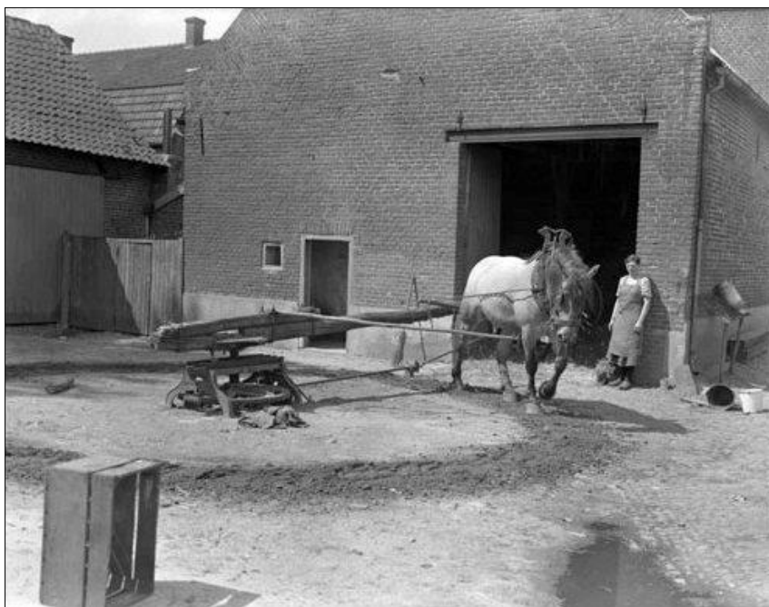
Fig. 13. Achterzijde van het pand, foto uit juli 1938. Een paard drijft de 'manege', de machinale maalinrichting aan. Foto collectie SGN.
