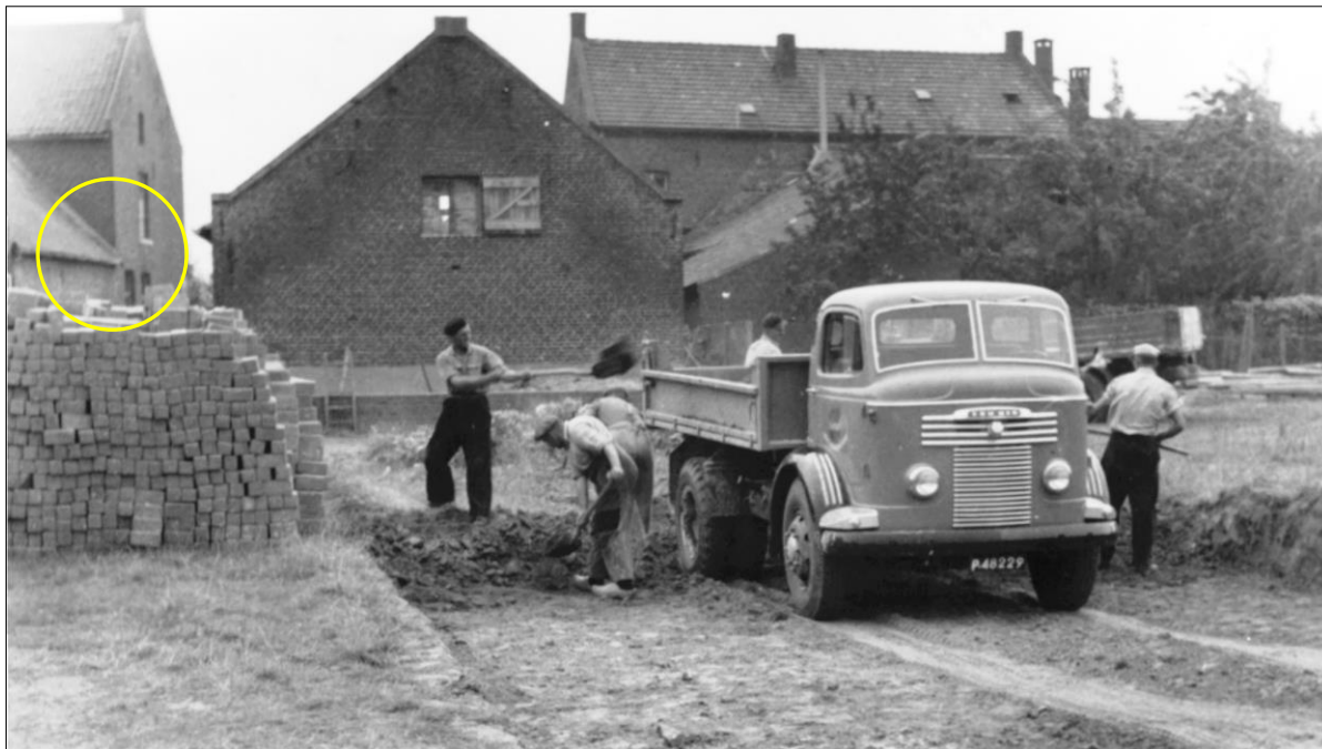
Fig. 25. Aansluiting van de achterbouw uit 1798 op de nieuwe woning uit 1879 (gele cirkel). Foto van W. Jonkers tijdens de aanleg van de aanleg van de Lindanusstraat, najaar 1955. Collectie SGN.
