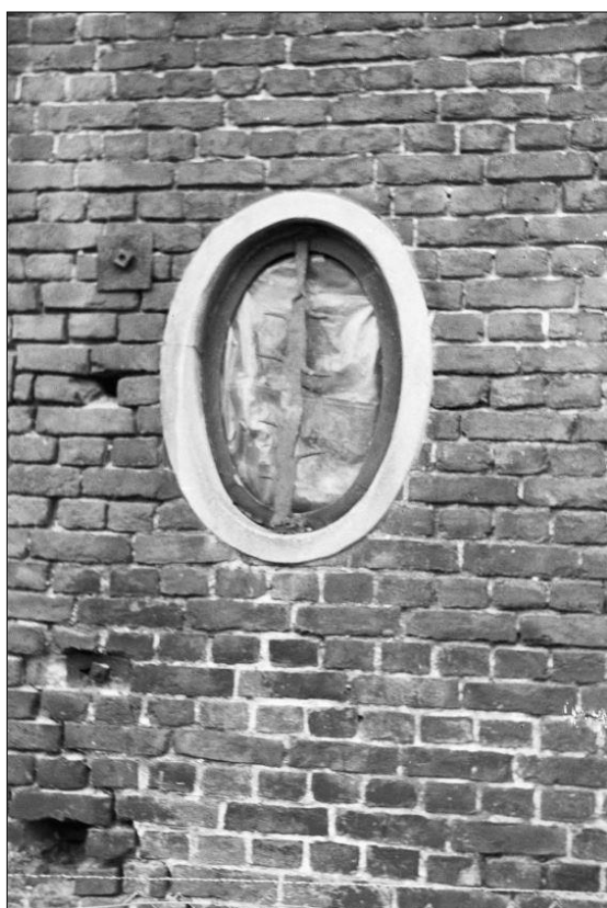
Fig. 7. Diefijzer in noordelijke zijgevel. Foto: RCE 150.651a Ab Warffemius.
