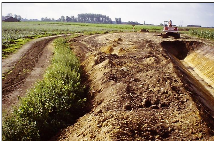
Fig. 13. Demping van de oude Boeketbeek (links) en aanleg van de gekanaliseerde beek (rechts).
