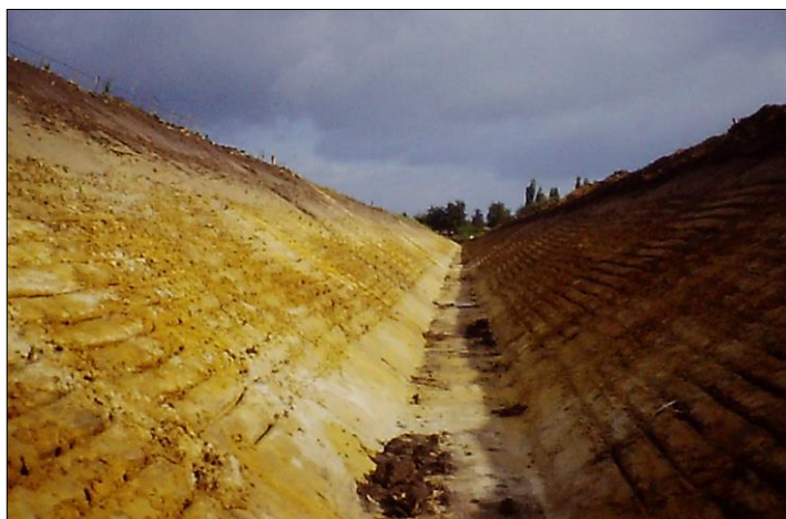
Fig. 16. Boeketbeek. Het profiel is voorzien van groeven ten behoeve van het inzaaien van graszaad.
