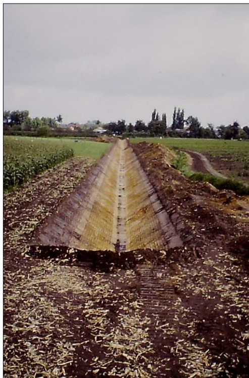
Fig. 15. Aanleg van de gekanaliseerde Boeketbeek.
