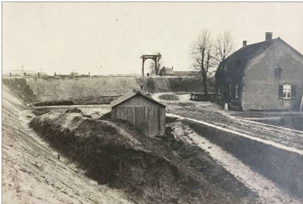
Fig. 25. Omgeving waar Matthijs Ridder zijn levenseinde vond. Rechts de bakkerij en herberg van Holten (in de huidige tijd bekend als 'Het Bruine Paard'). Op de achtergrond de ophaalbrug van Sluis 14. De foto is gemaakt tijdens de kanaalwerken van omstreeks 1920, waarbij de sluis kwam te vervallen. Foto archief Stichting Geschiedschrijving Nederweert.
