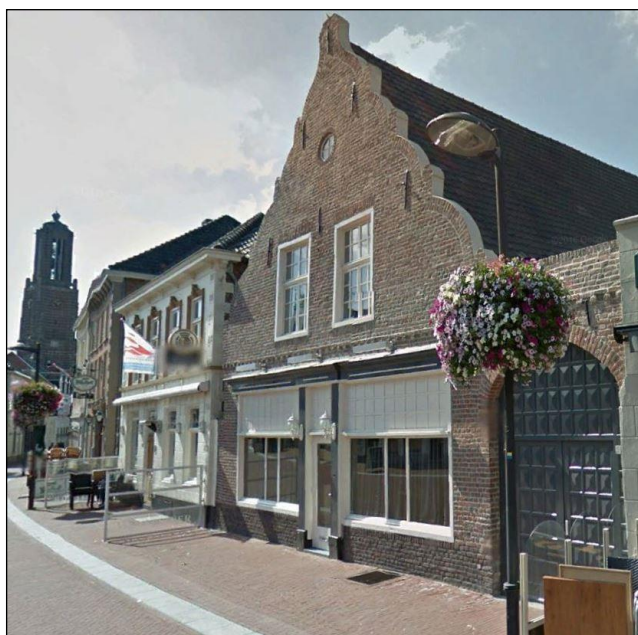
Figuur 2. Het pand Oelemarkt 11 (Situatie in 2017). Foto Google Streetview.
