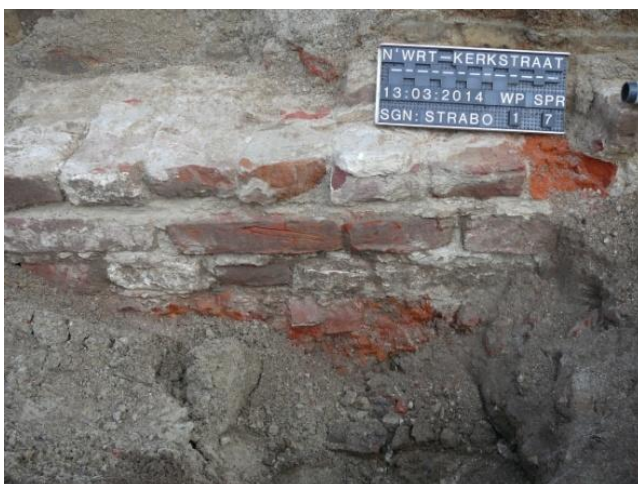
Figuur 35. Funderingsspoor bij kerk. Drie lagen steens muurwerk, waaronder vlijlaag (spoor 7).
