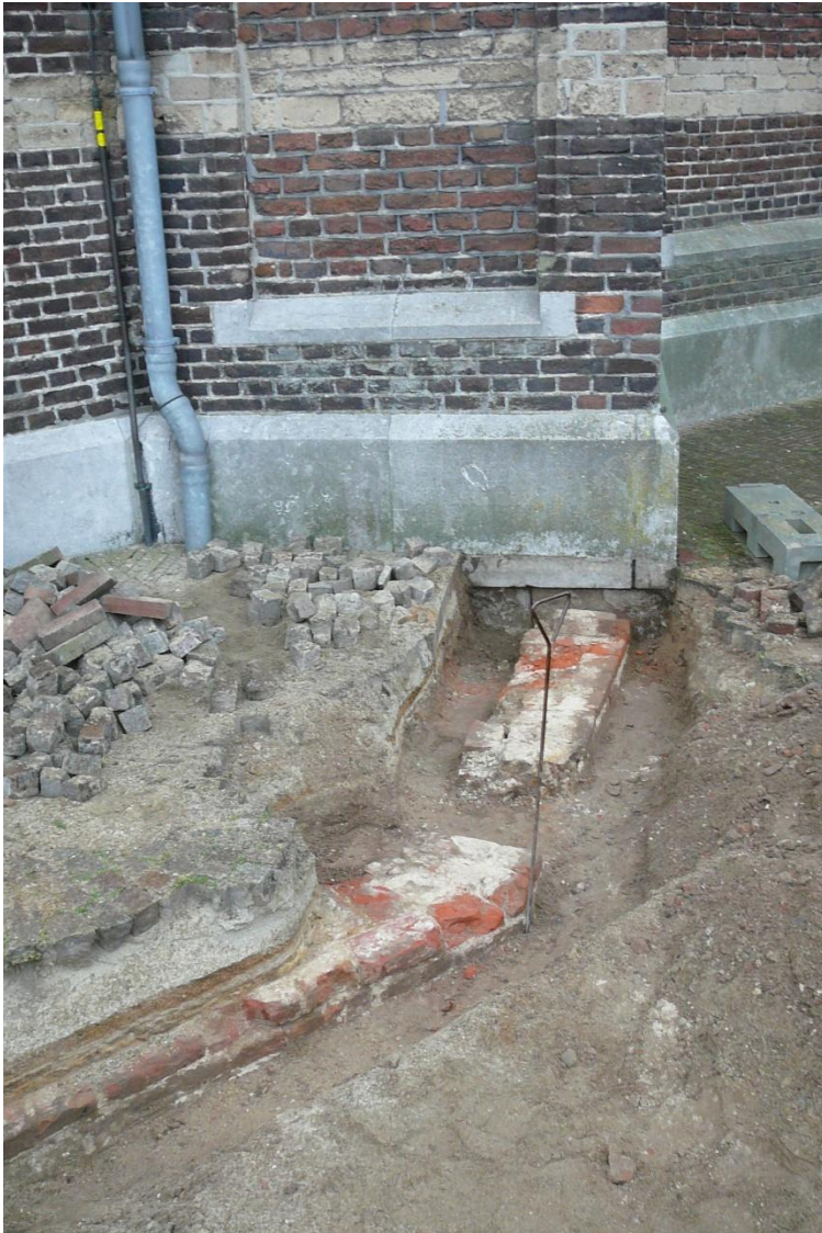
Figuur 47. Overzicht van de aangetroffen fundering en de aansluiting op de kerktoren.
