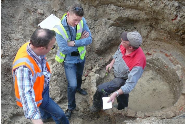
Figuur 34. Overleg over aanpak reconstructie waterput. V.l.n.r. Raimond Huynen (firma Bloem), John Metselaars (gemeente Nederweert), Teng Wijen.
