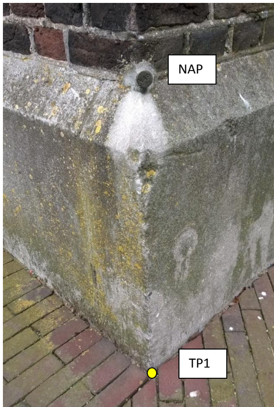
Figuur 8. NAP-bout 58A0163 in noordwestelijke hoektoren. De hardstenen hoek onder de NAP-bout op maaiveldhoogte vormt triangulatiepunt TP1.
