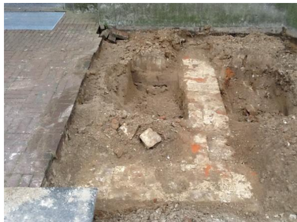
Figuur 53. Zuidelijke hoekdeel van dezelfde fundering.
