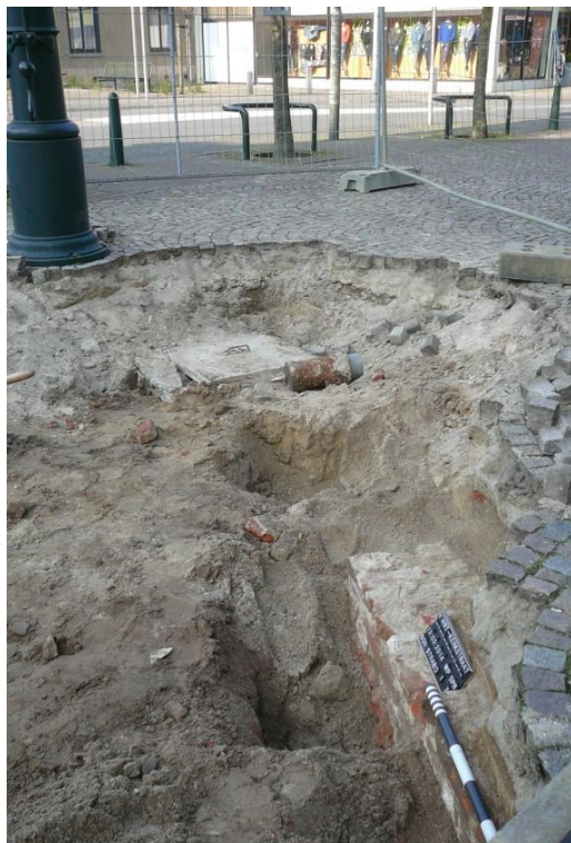
Figuur 38. In noordelijke richting was de fundering verstoord door subrecente werkzaamheden.
