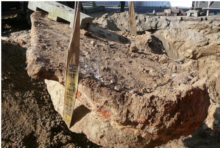
Figuur 20. Optillen van het betonnen deksel, dat als een 'prop' de bovenkant van de put vulde.
