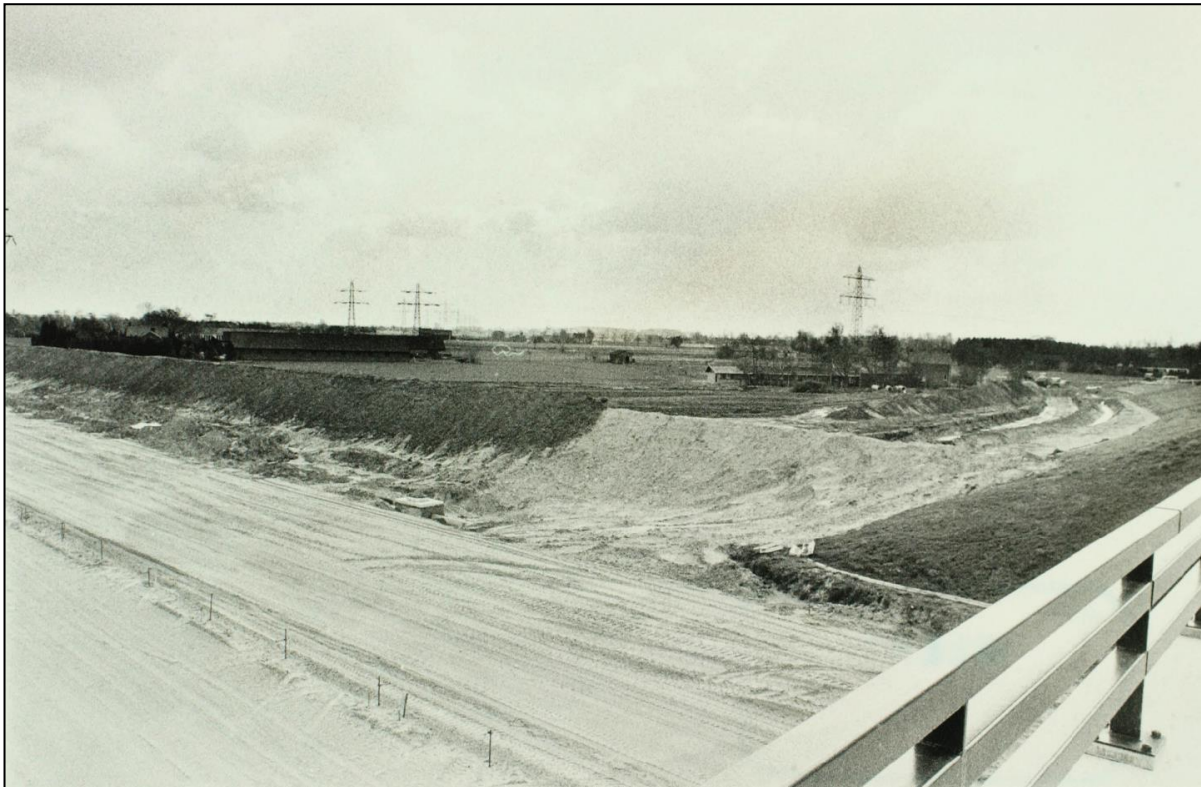
Fig. 7. Aanleg Slingertracé, de wegcunetten zijn gevuld met schoon zand. Afgebeeld is het viaduct in de Heugterbroekdijk, gezien naar het zuiden. Foto Beeldbank Erfgoedhuis Weert nr. A5481, foto Vincent van den Berg.
