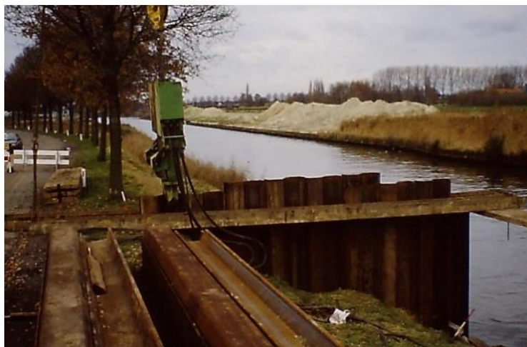
Figuur 3. Op de achtergrond de zandhopen van het riooltracé. Op de voorgrond is de hei-installatie bezig met de voorbereidingen voor de kruising met het kanaal. Foto Alfons Bruekers.
