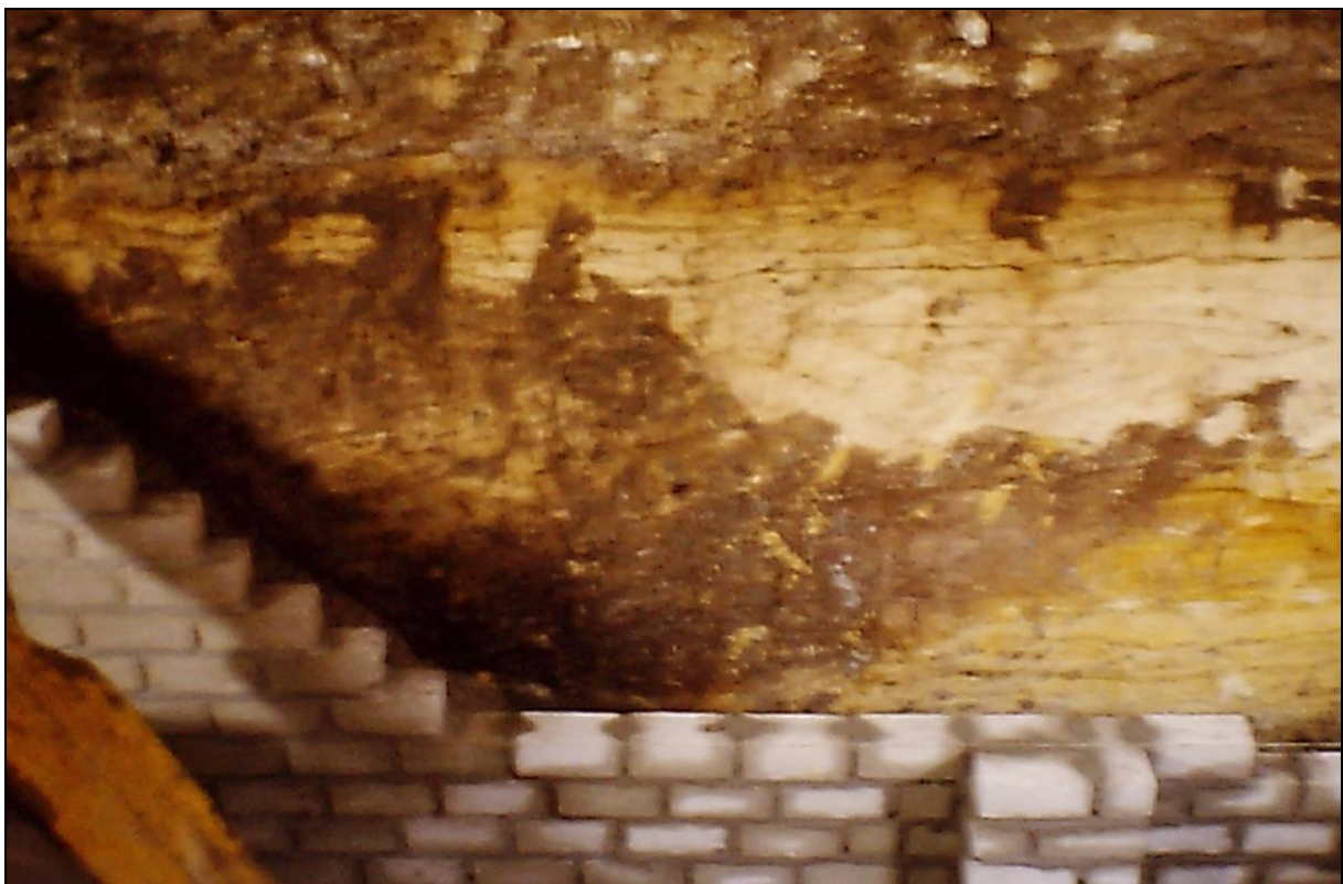
Figuur 12 Zichtbare gedeelte van het profiel van de gracht. Foto A. Bruekers.
