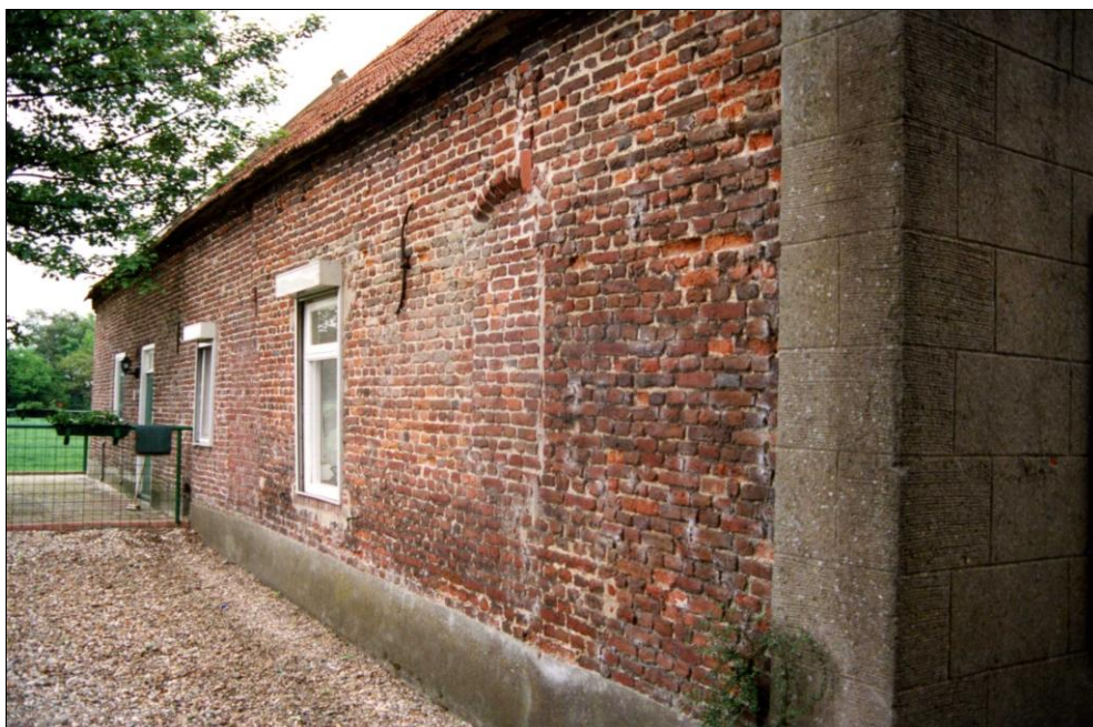
Figuur 7 Noordwesthoek van het woonhuis ter hoogte van P1. In het muurwerk is een laatmiddeleeuws raamvenster met geprofileerde stenen zichtbaar. Foto A. Bruekers.
