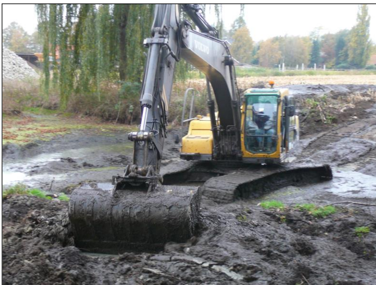
Figuur 7: Het verwijderen van de modderlaag. De graafmachine staat midden in de oude waterplas. Zicht op het zuidwesten.
