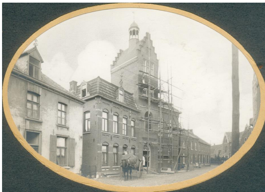
Fig. 11. De bijna voltooide bouw van het gemeentehuis in 1922. Foto: collectie Stichting Geschiedschrijving Nederweert.
