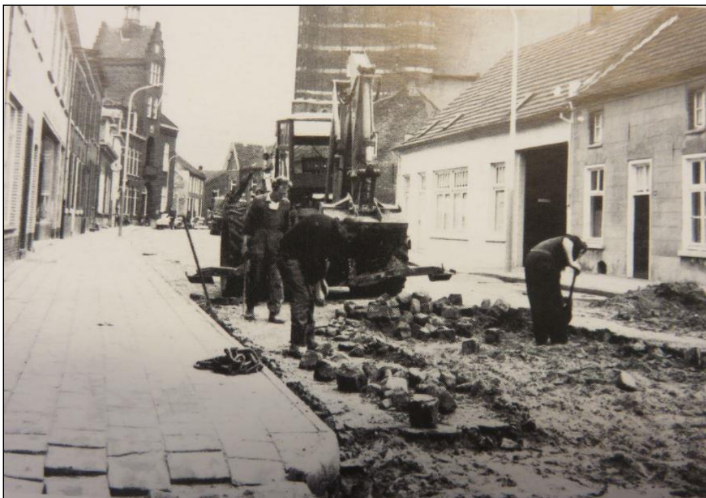
Fig. 4. Verwijdering van de oude keibestrating ten behoeve van de aanleg van het riool. De witte gevel rechts is van het pand van de firma Bruekers. Foto: collectie Jos Jonkers.
