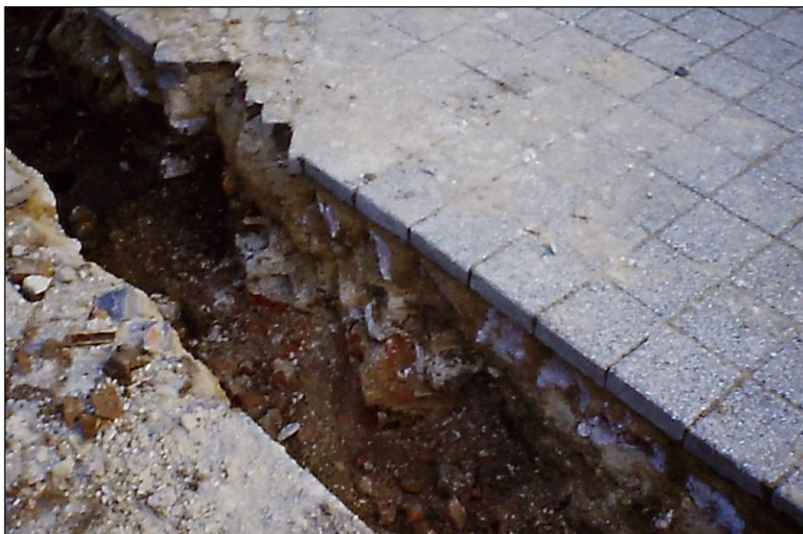
Figuur 5. Hoekfragment van een fundering, halverwege de leidingsleuf. Foto: Alfons Bruekers.
