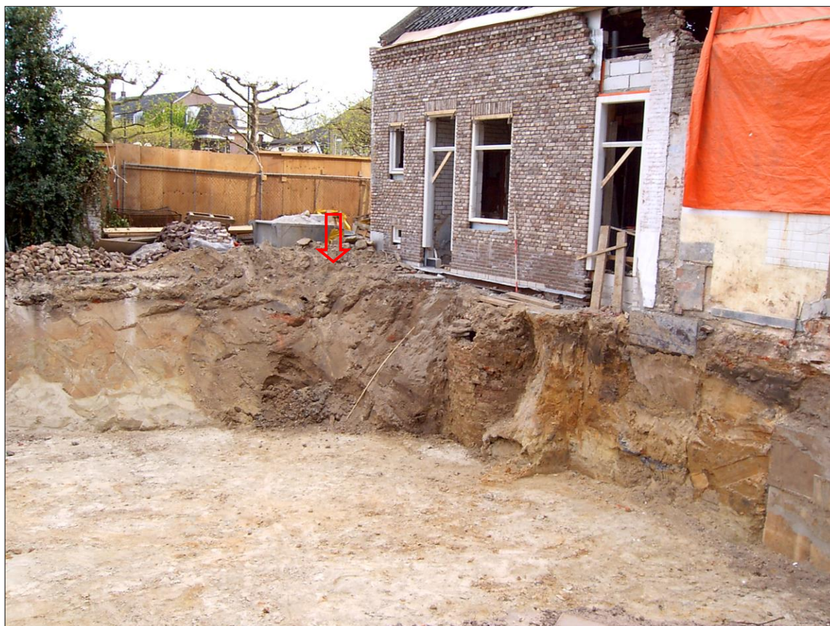
Fig. 16. In het midden (onder de rode pijl) de goed zichtbare donkergekleurde trechtervormige insteek van een waterput. Foto: Alfons Bruekers.
