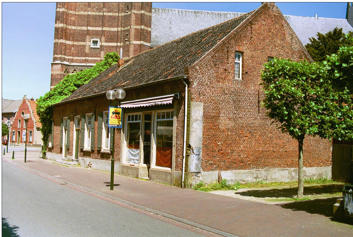
Fig. 29. Pand 'Siem' aan de vooravond van de restauratie. Foto: collectie SGN.
