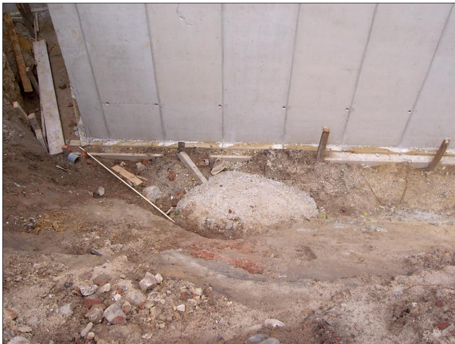
Fig. 22. Betonprop op de plek van de kern van de waterput.
