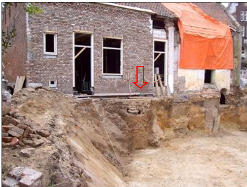
Fig. 11. In het midden (rode pijl) onder de oostgevel een bakstenen waterput.
