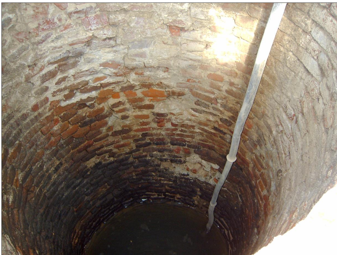
Fig. 14. Inwendige van de bakstenen waterput, met loden waterleiding.
