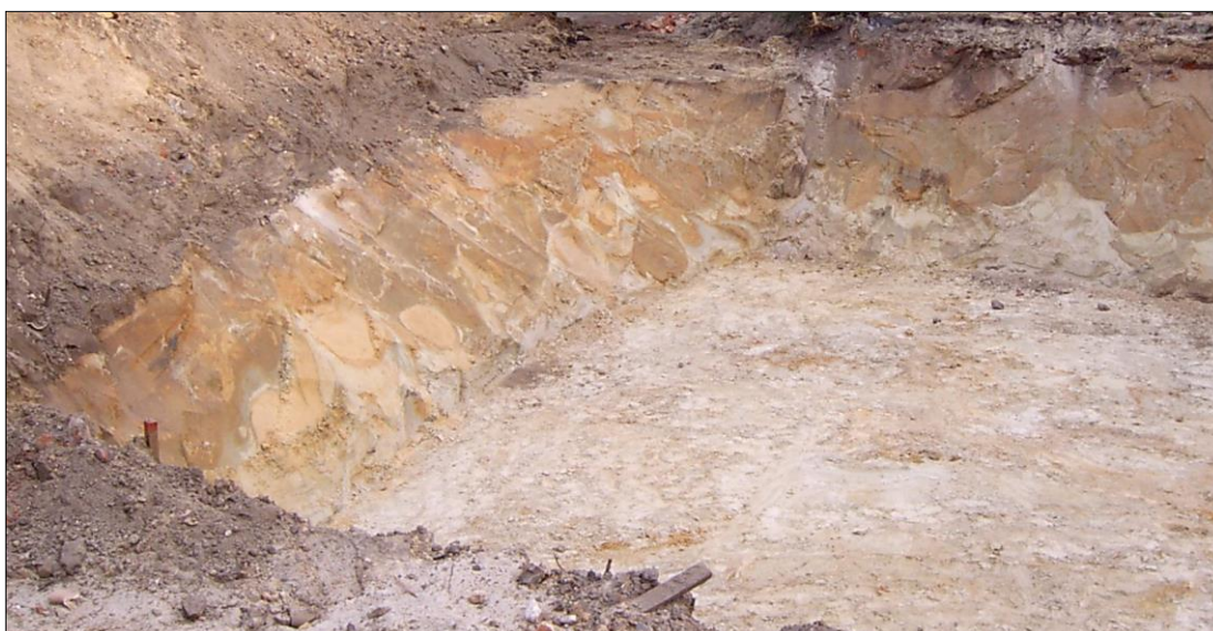
Fig. 8. Sterke sporen van cryoturbatie in de onderste zone van de bouwput.
