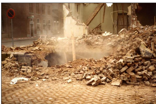
Figuur 3 en 4. Verwijdering van puin en instorting van de keldergewelven. Foto firma Smolenaers.
