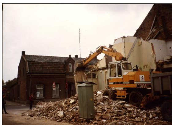
Figuur 3 en 4. Verwijdering van puin en instorting van de keldergewelven. Foto firma Smolenaers.
