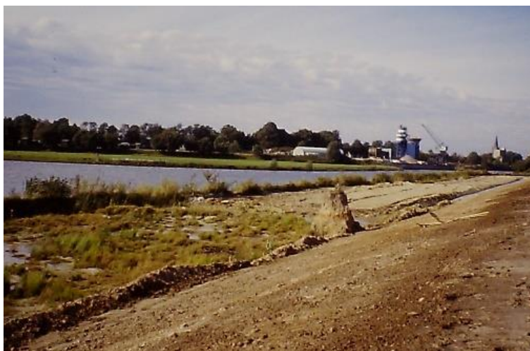
Figuur 3. Het talud van de nieuwe kanaaloever met zicht op de kanalenkruising, na het machinale uitgraven.
