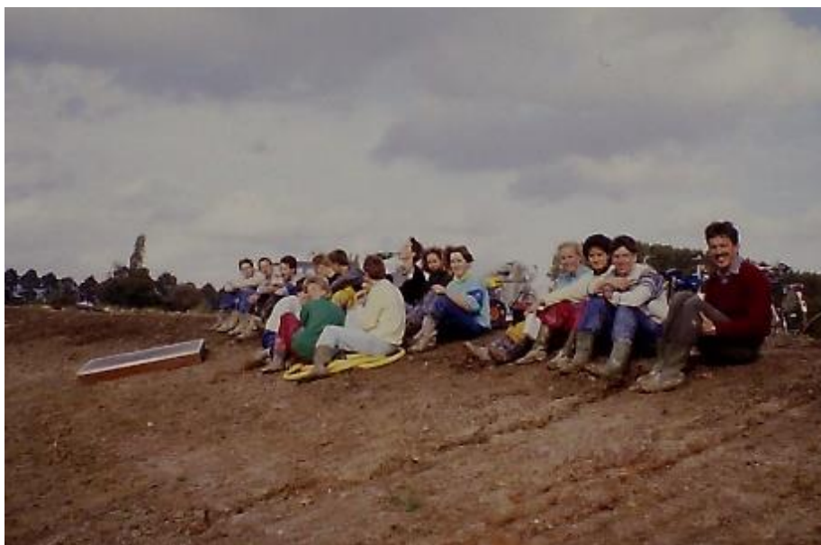
Figuur 15. De voltallige graafploeg tijdens de middagpauze op het talud van de nieuwe kanaaloever.
