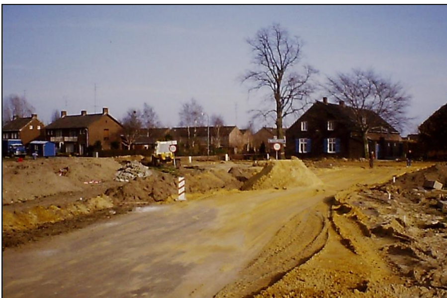
Fig. 3. Situatie bij aanvang van de opgraving. Gezien naar het zuidoosten. Rechts van het midden de lindenboom met kruis. Foto A. Bruekers.
