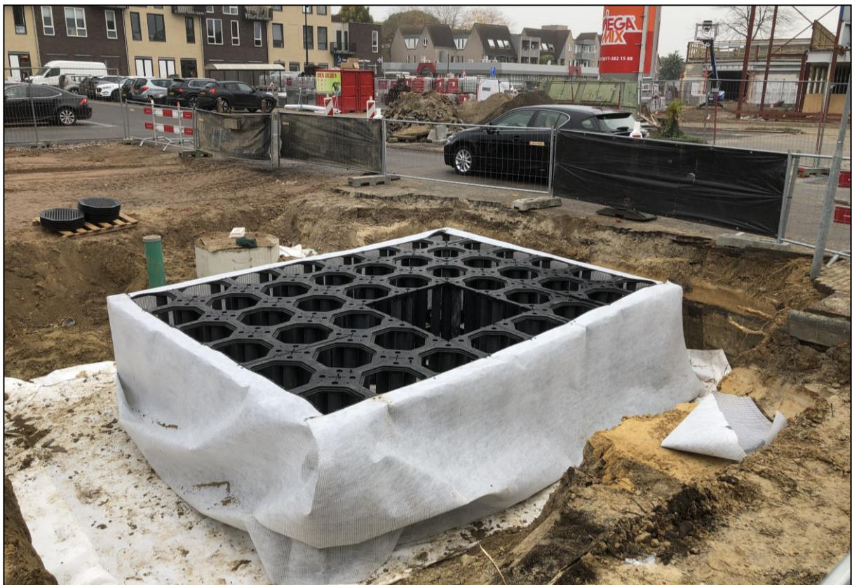
Fig. 12. Uitzicht op krattenblok nr. 1 en betonput A. Opgemerkt dient te worden dat het krattenblok, anders dan is aangegeven op de bestektekening, ca. 3m zuidelijk is gerealiseerd dan gepland. Foto: STRABO.
