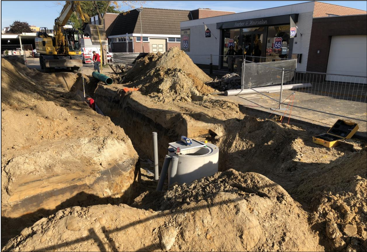
Fig. 11. Uitvoering van graafwerkzaamheden t.b.v. waterinfiltratieleidingen. Foto richting noorden, zicht op betonput B. Duidelijk is te zien dat de onderste helft van de oude bouwvoor intact aanwezig is. Foto: STRABO.
