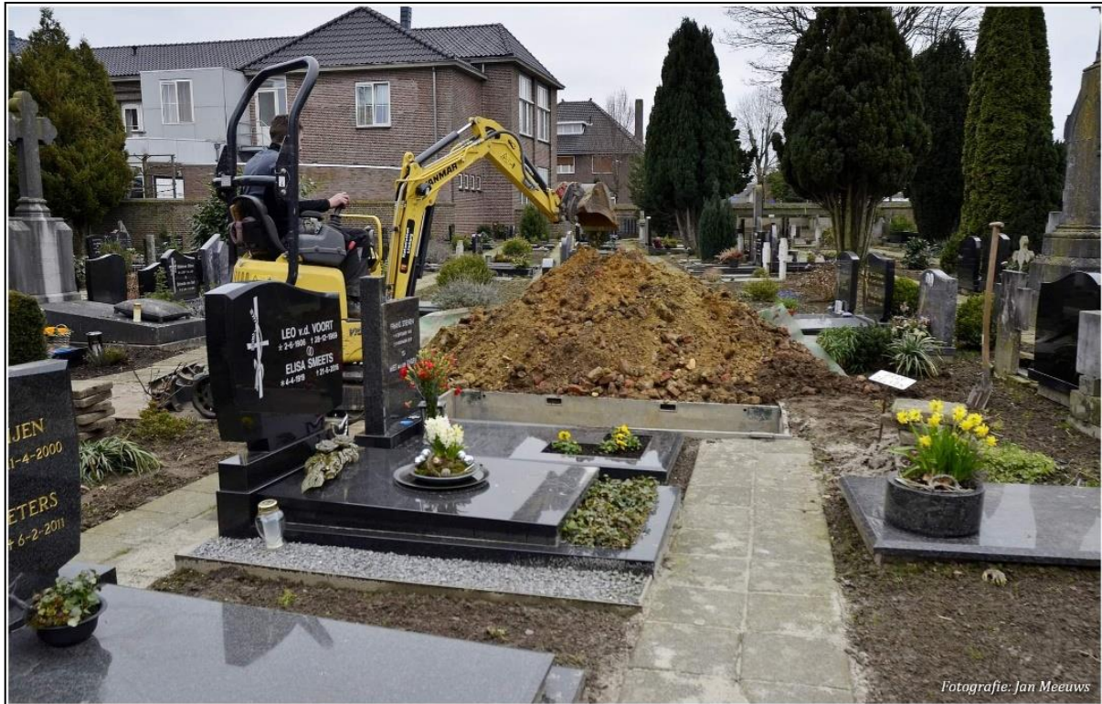
Fig. 2. Beeld van de graafwerkzaamheden. Foto: Jan Meeuws.
